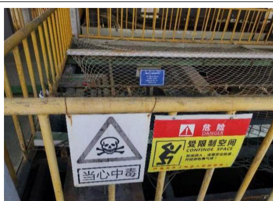
图 15 综合一级反应池安全警示标志
